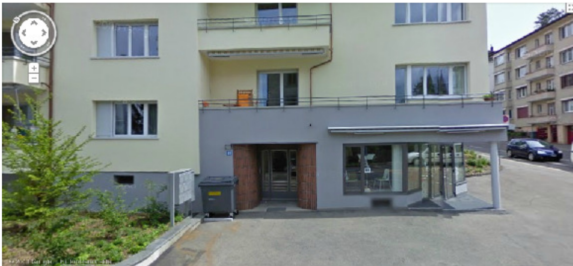
Einwärts versetzter Eingang mit ebenfalls einwärts versetzten Dach und markierenden Säulen, Freiestr. 93, 8032 Zürich (Google Earth)
