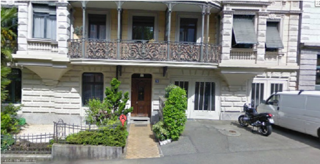
Nur leicht einwärts versetzter Türraum mit Balkonboden als Dach, Konkordiastr. 25, 8032 Zürich (Google Earth)
