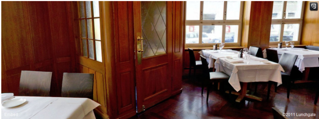
Einwärtiger beidwärts abgeschlossener Türraum. Restaurant Convivio, Rotwandstr. 62, 8004 Zürich (Photo: Lunchgate)
